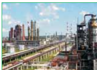
Бакинский нефтеперерабатывающий завод
